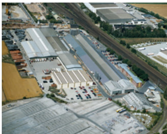
Zakład produkcyjny Marley Deutschland GmbH.
